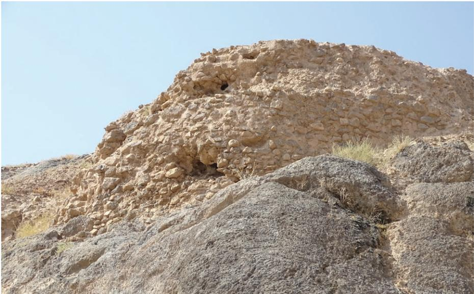
Abb. 62: Blick von Westen auf Bruchstein-Mörtel Mauerwerk der Zitadelle (Aufnahme: A. Mittertrainer)
