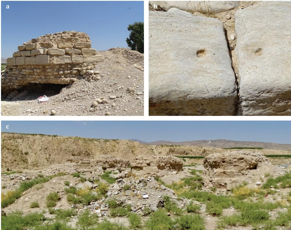
Abb. 41: Pol-e Ahmad Abad: **a** Detail des nordöstlichen Brückenpfeilers; **b** Detail der Aussparungen für Eisenklammern; **c** Blick von Osten auf die Brücke (Aufnahmen: A. Mittertrainer)
